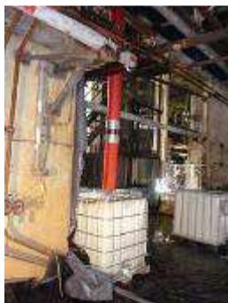
purge d'une canalisation BTS
