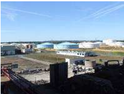
cuves SPBA vues de la centrale
