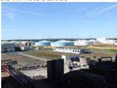
site SPBA vu de la centrale
