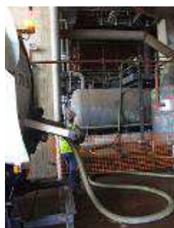
purge d'une cuve à l'aide de l'hydrocureur
