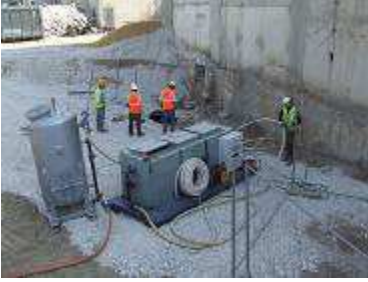
pompage des eaux résiduelles avec passage
