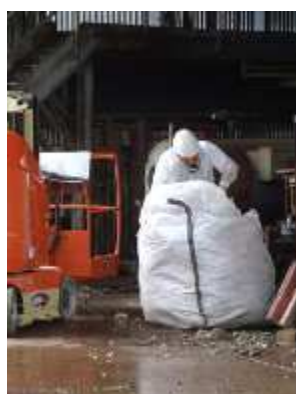
stockage du calorifugeage en big-bag
