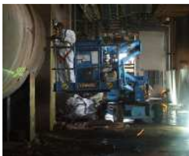
dépose joint bâche
