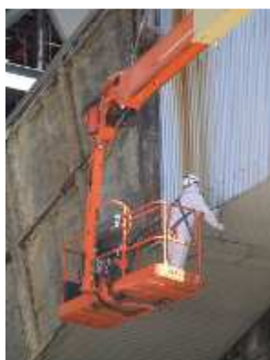
décalorifugeage d'un réchauffeur
