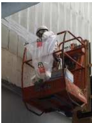
dépose mastic bardage vitré
