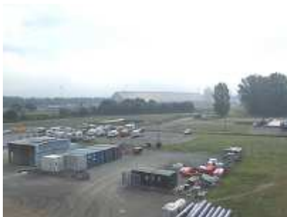
site YARA vu de la centrale
